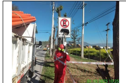
Mantenimiento y conservación de señales verticales
