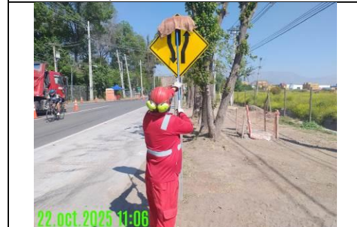
Mantenimiento y conservación de señales verticales
