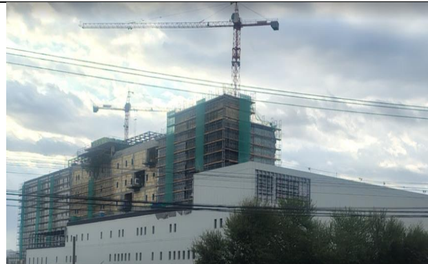
2.- Fachada Sur Oriente
