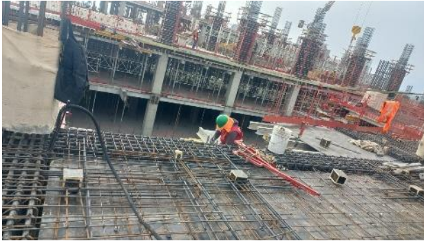
Trabajos de enfierradura
