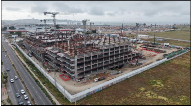
Vista aérea avance de obra
