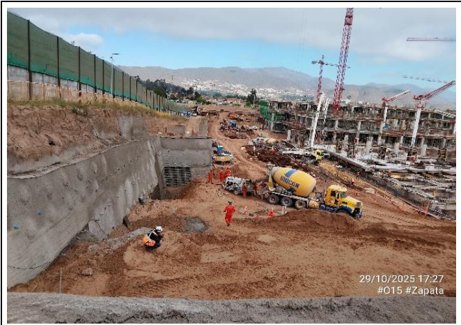
Sistema Soil Nailing - Refuerzo de Talud 3
