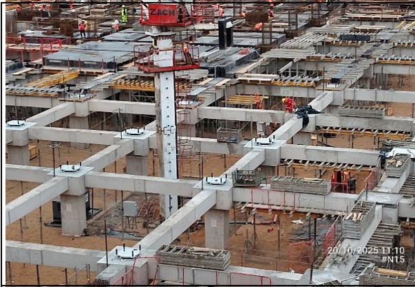
Vigas Aislación S1 (Sector A)
