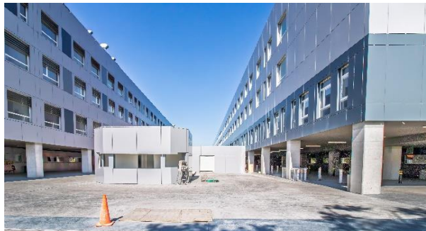
Fachadas ING y HDS
