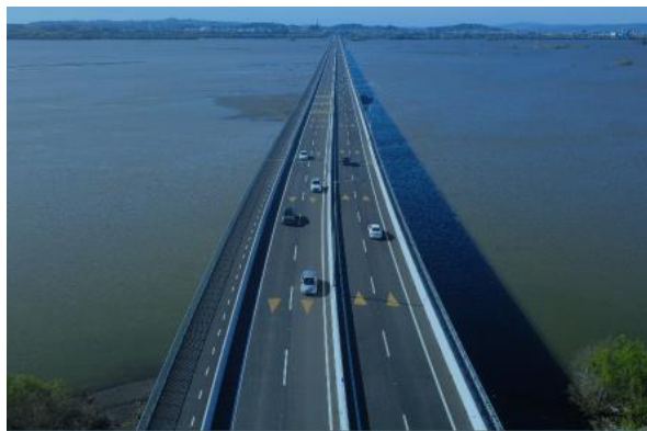
Sector B –Desde estribo Entrada norte – Hualpén
