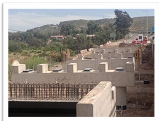
Foto 2: Ruta 5, Puente Quebrada Seca, vista general estribo de salida y cepas.
