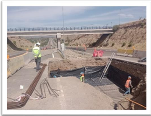
Foto 5: Ruta 5, Pasarela Salala, Excavación de para fundación en la mediana.
