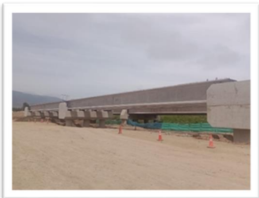
Foto 1: Ruta 5, Puente Huentelauquen Oriente, montaje de vigas.
