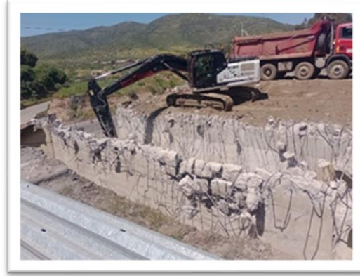
Foto 4: Ruta 5, Atravesio Puerto oscuro, Proceso de demolición.
