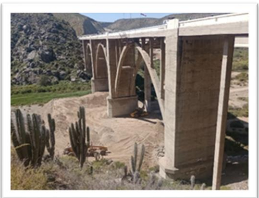
Foto 3: Ruta 5, Puente Limarí, vista general de plataforma de trabajo.
