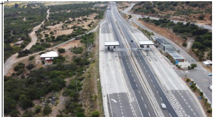
Peaje Túnel El Melón (km 127.9)
