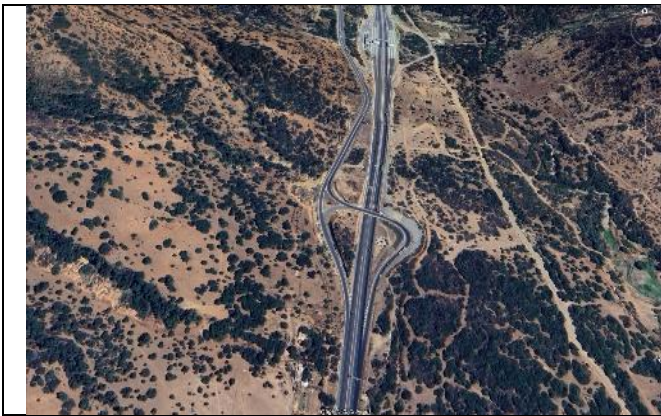
Inicio Concesión Túnel El Melón (km 124.54)
