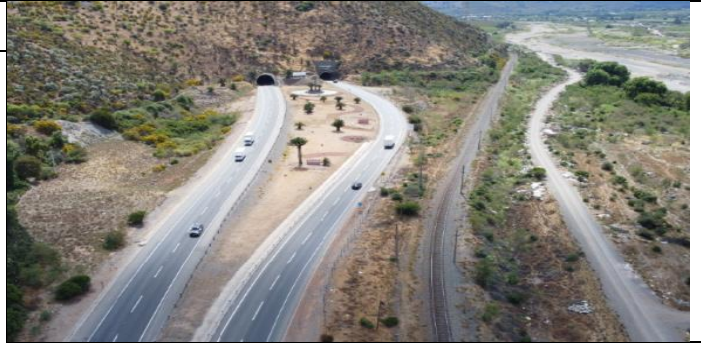
Acceso Sur Túnel La Calavera (km 93.6)
