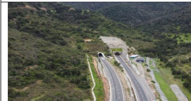
Acceso Sur Túnel El Melón (km 129)
