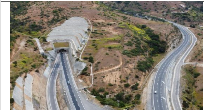
Acceso Norte Túnel El Melón (km 135)
