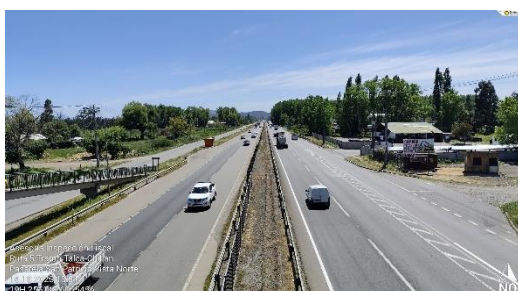
Dm 274,930 – Panorámica Vista Norte Pasarela San Patricio.
