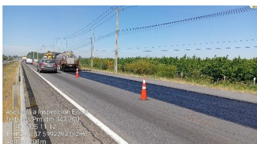
Dm 343,700– Panorámica Trabajos en Pista, Lado Poniente.
