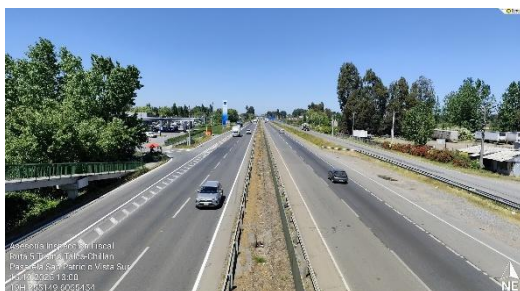
Dm 274,930 – Panorámica Vista Sur Pasarela San Patricio.
