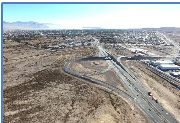
Enlace Acceso Sur a Calama
