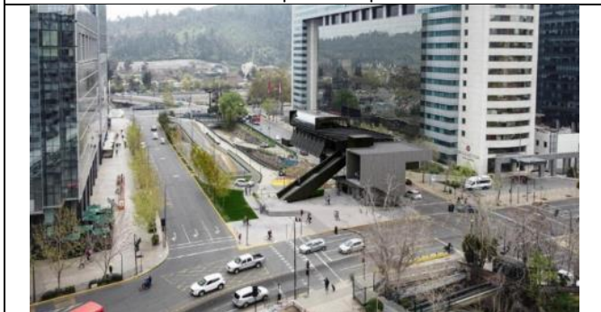
Estación Canal San Carlos
