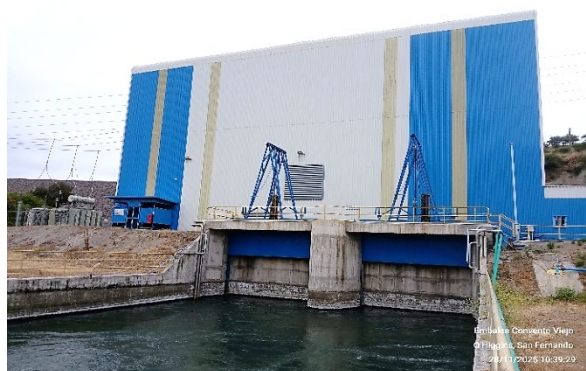
Imagen N°4. Vista general de la Central Hidroeléctrica.
