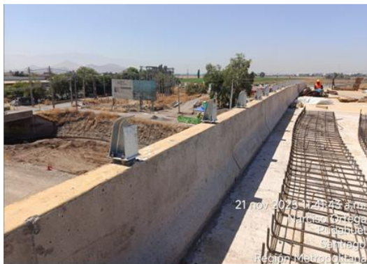
Pasamanos enlace acceso norte tramo B4
