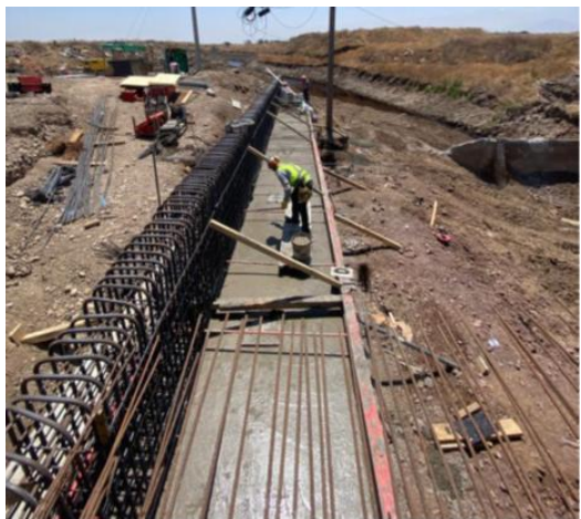
Dintel Fase 2 Puente Las Cruces 1
