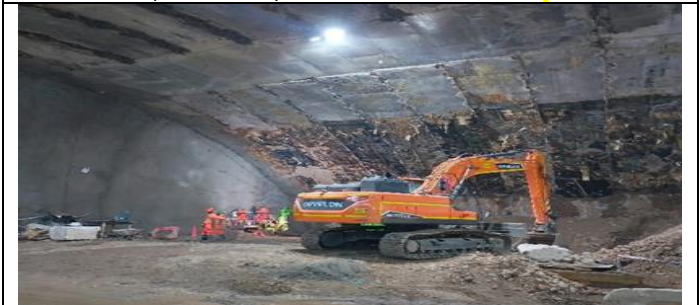
Túnel Alemán: Se inició excavación por fase 4 (lado poniente). El avance actual en excavación es de 80 m en fase 1, 80 m en fase 2, 50 m en fase 3 y 20 m en fase 4.
