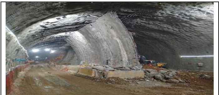
Túnel Híbrido sección D, de transición de túnel híbrido a túnel alemán, Dm 8.375,53 a Dm 8.429,91 (54,38 ml), se termina excavación y sostenimiento por fases 1, 2 y 3 en marco 140, Dm 8.429,32.
