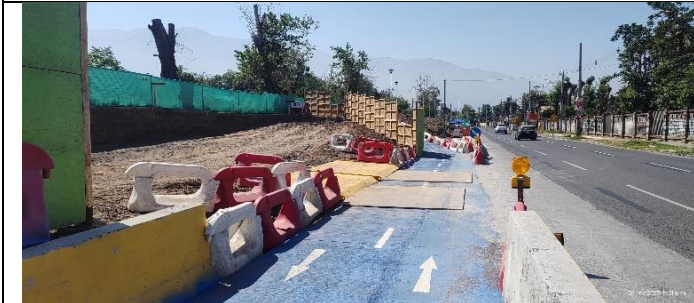
Desvío Acueducto Paralelo (Agua Potable)
