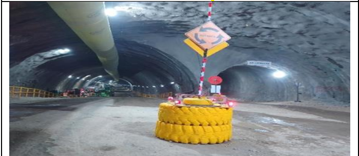
En Caverna Salida Tobalaba Oriente (CSTO), se realizó cale con la vía expresa Oriente el 14/11/25.
