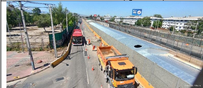
Desvío Trinchera Expressa Oriente
