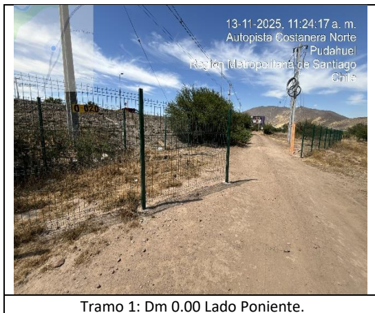
Tramo 1: Dm 0.00 Lado Poniente.
