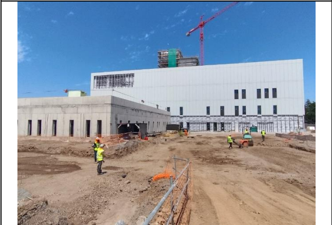
4.- Fachada Norte-Acceso principal
