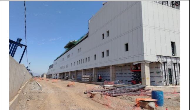
2.- Fachada Sur Oriente
