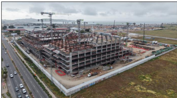
Vista aérea avance de obra
