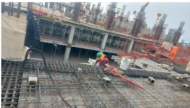
Trabajos de enfierradura
