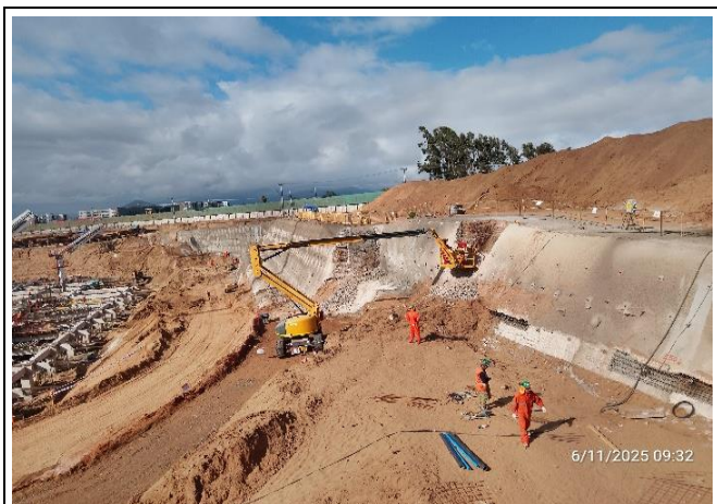
Sistema Soil Nailing - Refuerzo de Talud 7
