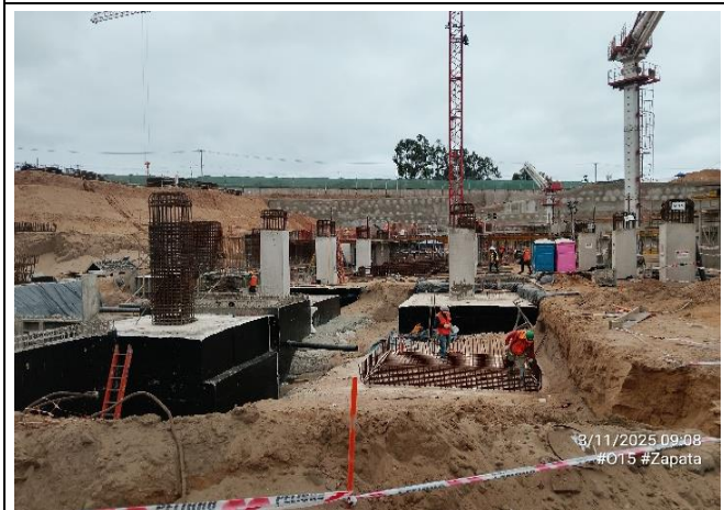
Fundaciones Planta Elevadora (Sector D)
