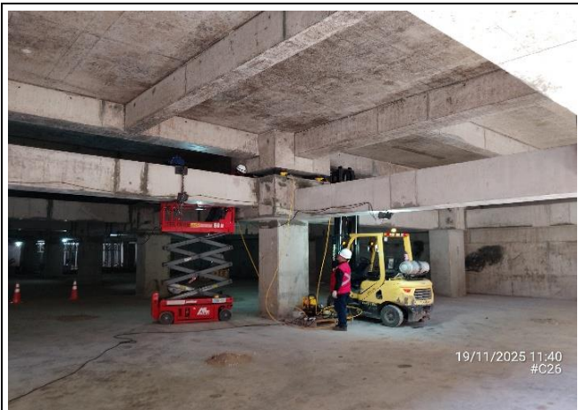
Reemplazo dummies por Aisladores (Sector F)
