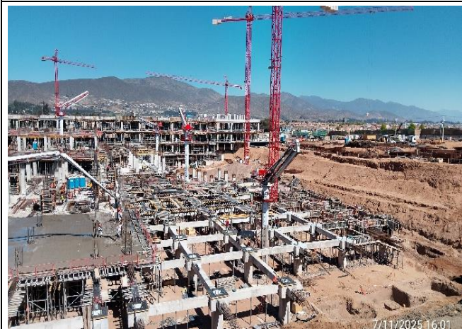
Vista Panorámica Sector B (desde el poniente)
