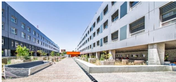
Fachadas ING y HDS
