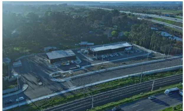
Sector C – Edificio de Control y Emergencias
