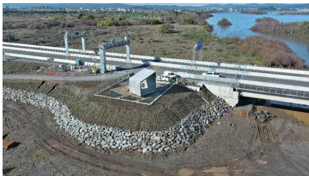
Sector A – Mirador – Hualpén
