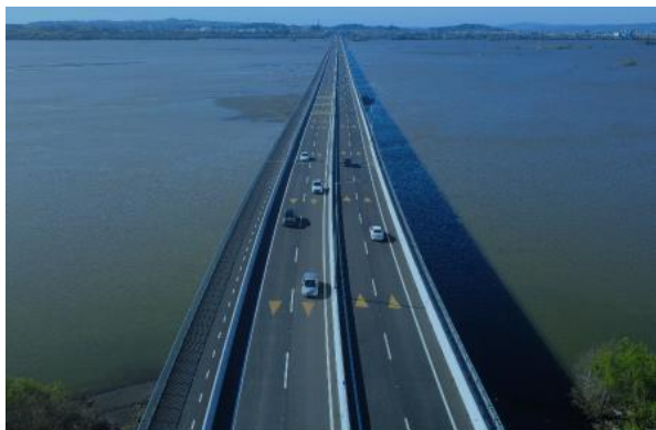
Sector B –Desde estribo Entrada norte – Hualpén
