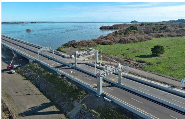
Sector A – Pórticos telepeaje – Hualpén
