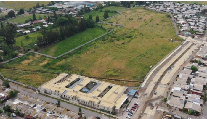
Figura – Terreno de construcción Hospital de Rengo
