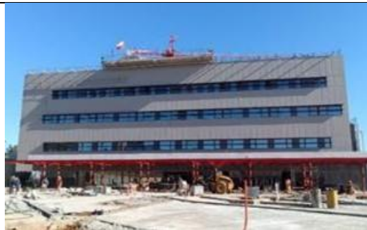
Vista General Suroriente Edificio Principal HCN
