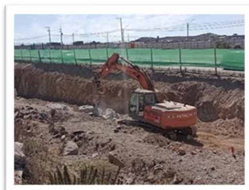
Foto 6: Ruta Paso inferior Avda. Panorámica, retiro de roca con martillo hidráulico.
