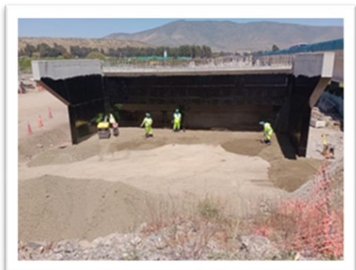
Foto 1: Ruta 5, Puente Huentelauquen Oriente, ejecución de relleno estructural en estribo de salida.
