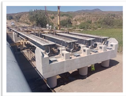
Foto 2: Ruta 5, Puente Quebrada Seca, cepa 1 en condiciones de recibir montajes de vigas.
