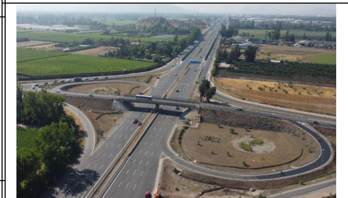
Enlace Batuco Liray (km 25.5)
