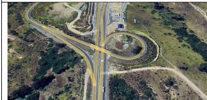
Término Concesión Túnel El Melón (km 132.73)
