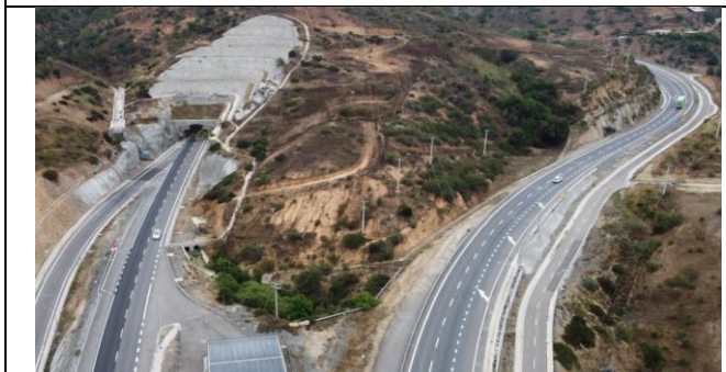
Acceso Norte Túnel El Melón (km 135)
