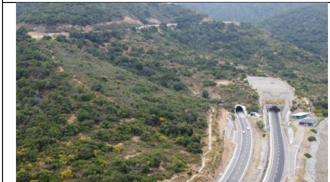
Acceso Sur Túnel El Melón (km 129)
