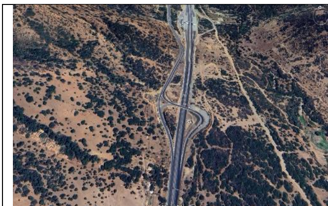
Inicio Concesión Túnel El Melón (km 124.54)
