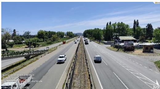
Dm 274,930 – Panorámica Vista Norte Pasarela San Patricio.
