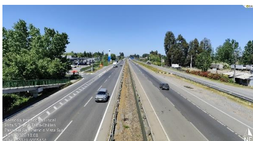
Dm 274,930 – Panorámica Vista Sur Pasarela San Patricio.
