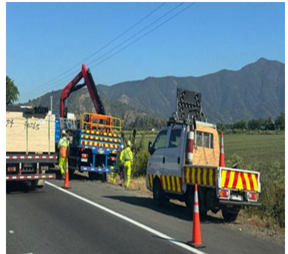
Reparación de señales verticales Km. 49+700- Descendente
