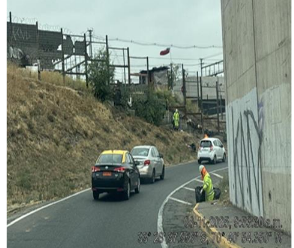
Mantencción y limpieza de faja km.2+500- Descendente
