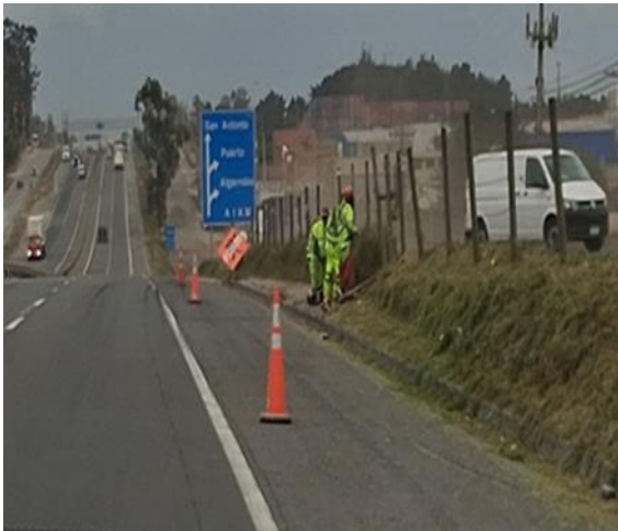
Roce Manual Km. 100+400- Ascendente
