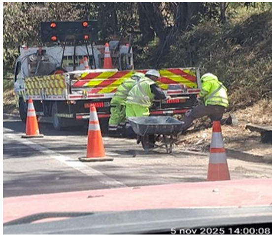
MantenCIÓN Alcantarillas Km. 105+450- Ascendente
