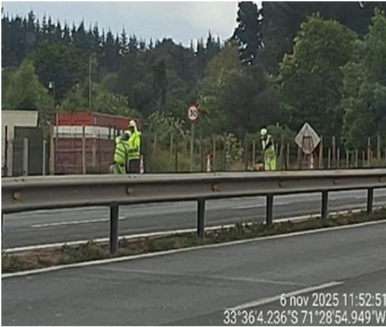
Reposición Cercos Km. 91+300- Descendente
