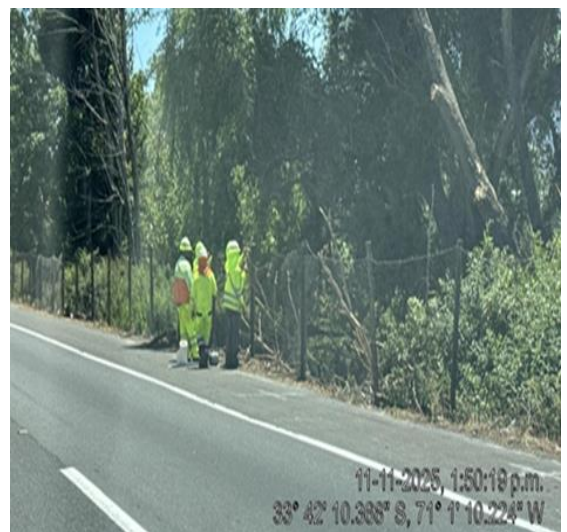
Reparación de cercos Km. 48+500- Ascendente
