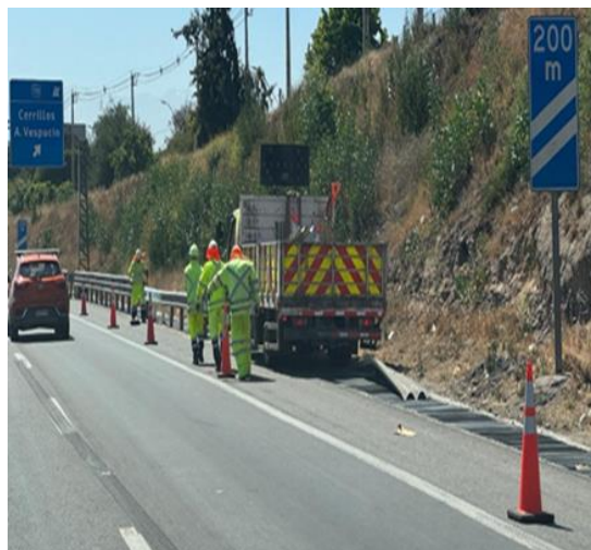
Instalación de Barreras Km. 9+700- Ascendente
