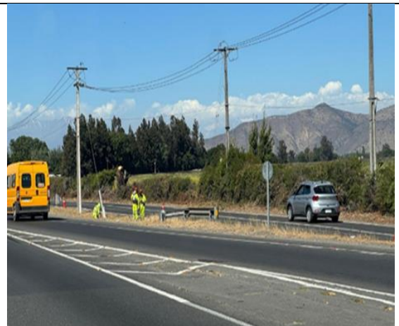
Limpieza y mantención de Faja km. 38+300 Descendente
