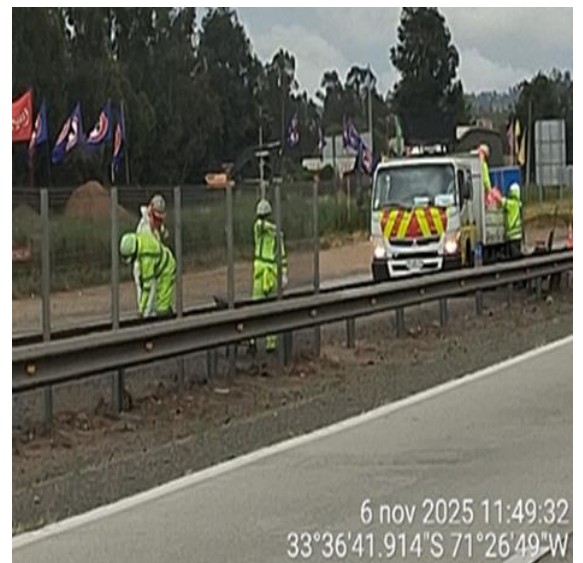
MantenCIÓN berma Km. 91+300- Mediana
