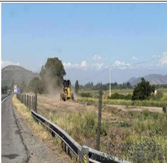
Roce Mecanizado Km. 58+400- Descendente
