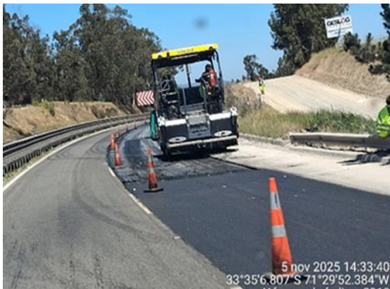
MantenCIÓN Pavimento km. 97+180 Pista 4
