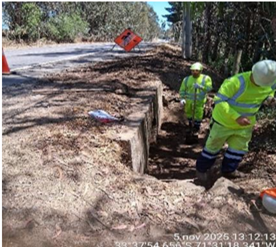
Limpieza de Alcantarilla km. 8+663 – G-904
