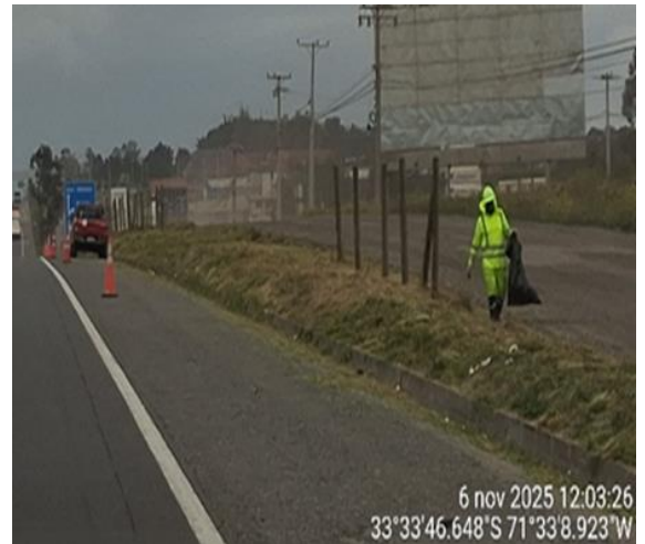
Limpieza de faja km.103+000- Ascendente
