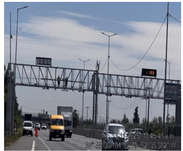
Mantenimiento de pórticos Km. 32+900- Ascendente
