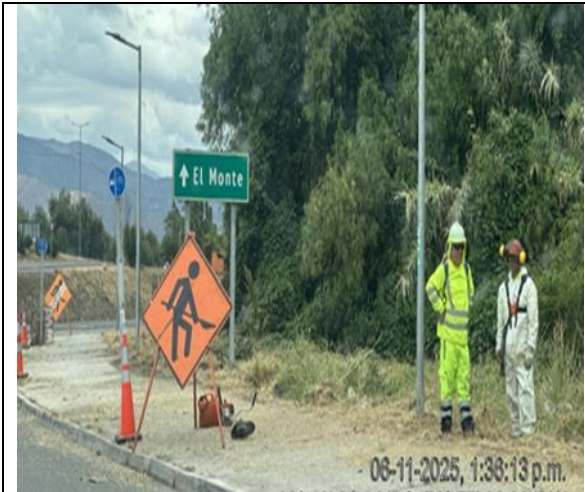
Roce Manual km. 28+600 Ascendente
