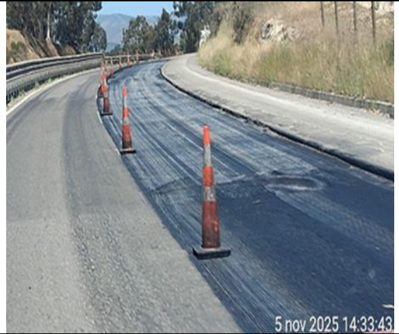
MantenCIÓN de Pavimento Km. 97+120- Pista 4
