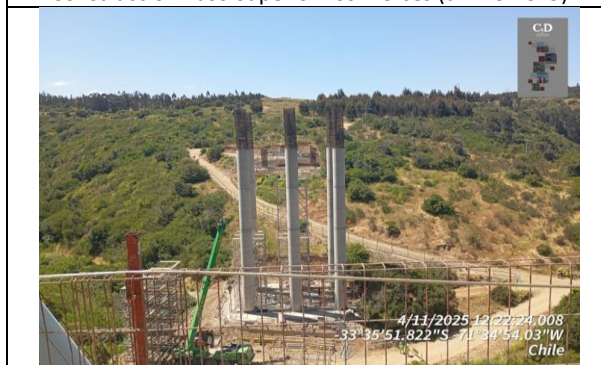
Construcción Viaducto Las Lajas (dm 136.200 - 136.652)
