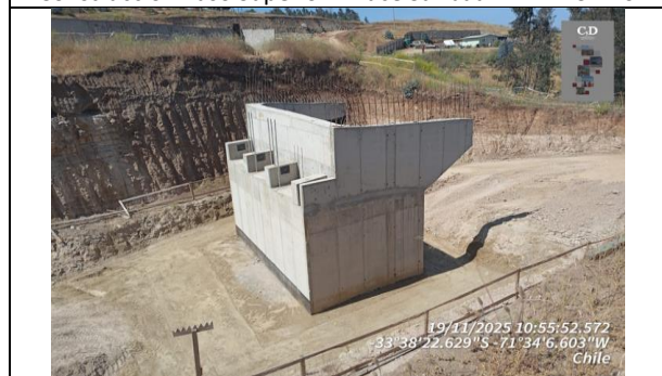
Construcción Paso Inferior Conexión Ruta G-908 Dm 130.408
