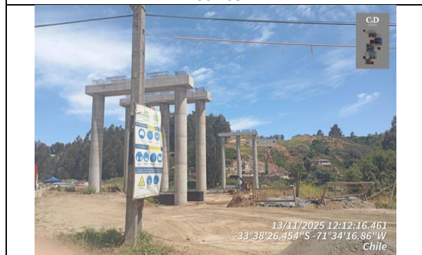
Construcción Viaducto San Juan Dm 130.599 - 130.959
