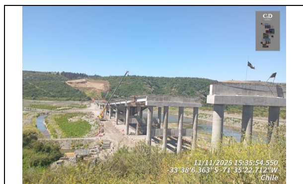
Construcción Viaducto Maipo, Dm 125.309
