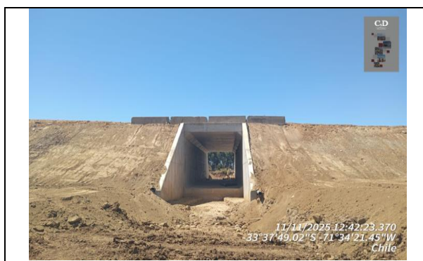
Construcción Paso Superior Interpredial N°132 Dm 132.255
