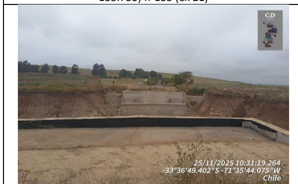
Construcción Paso Superior Los Alerces (dm 132.679)
