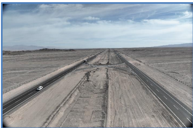
Paso de Emergencia Dm 88.500
