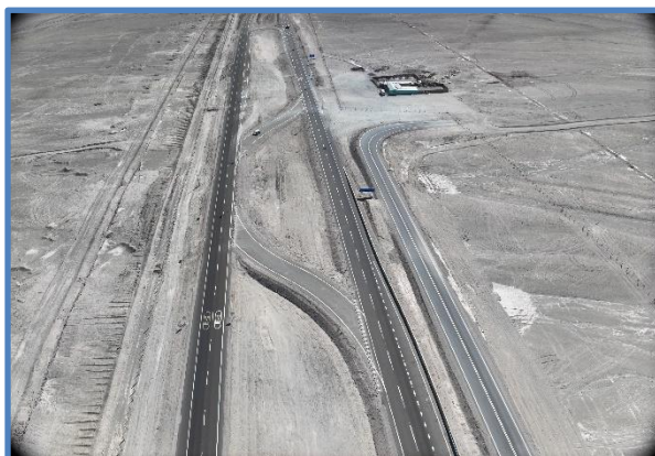
Paso de Emergencia Dm 82,260
