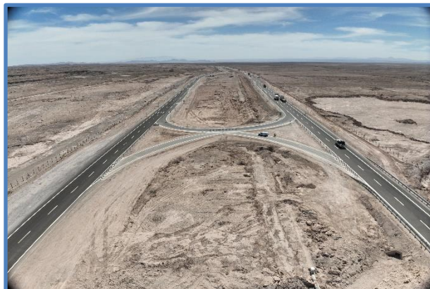
Paso de Emergencia Dm 10,900
