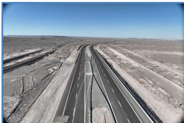
Paso de Emergencia Dm 78.160
