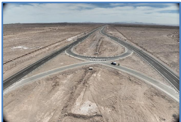
Paso de Emergencia Dm 14,900
