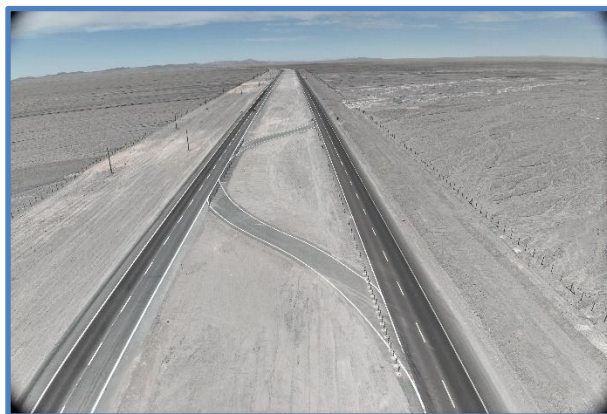
Paso de Emergencia Dm 62,200
