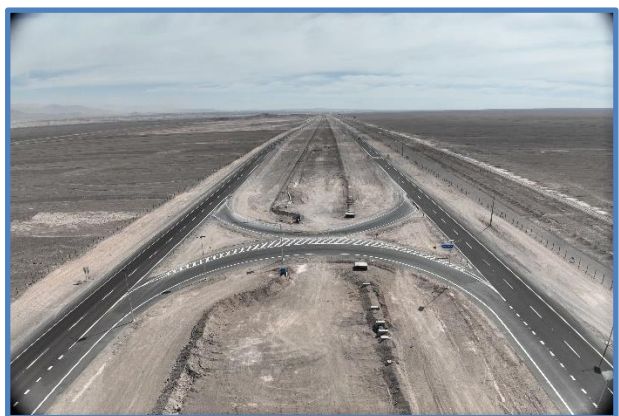
Paso de Emergencia Dm 98.520
