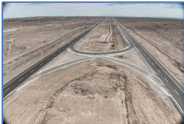
Paso de Emergencia Dm 6,600
