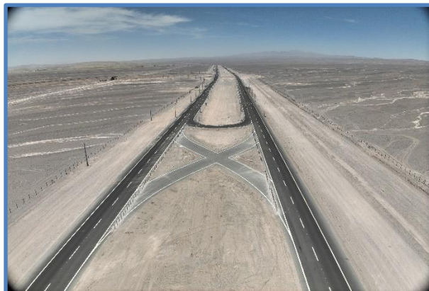
Paso de Emergencia Dm 52,200
