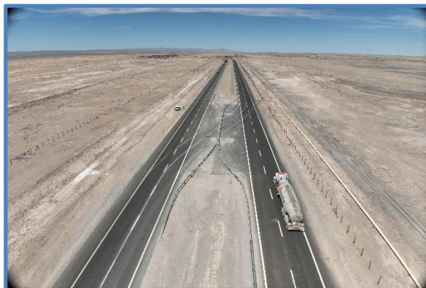
Paso de Emergencia Dm 21,100
