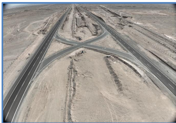
Paso de Emergencia Dm 93,100
