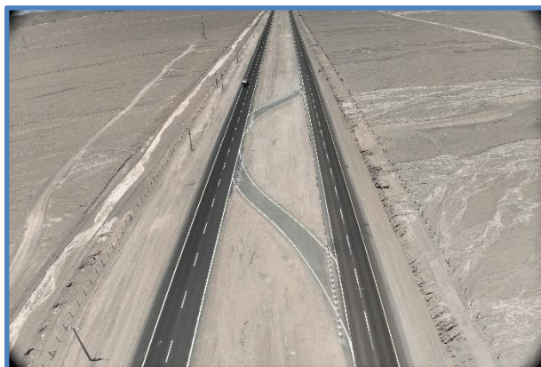
Paso de Emergencia Dm 68.100
