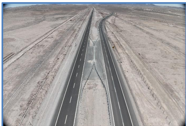
Paso de Emergencia Dm 25,300
