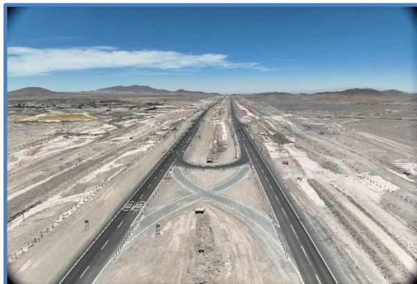
Paso de Emergencia Dm 37,200
