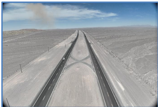
Paso de Emergencia Dm 57.300
