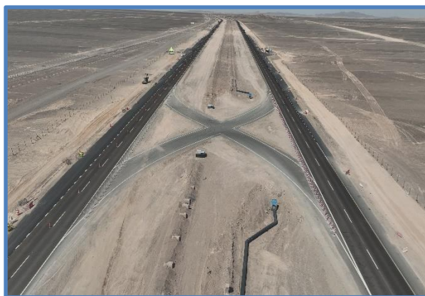
Paso de Emergencia Dm 103,500
