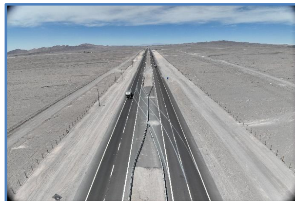
Paso de Emergencia Dm 72,200
