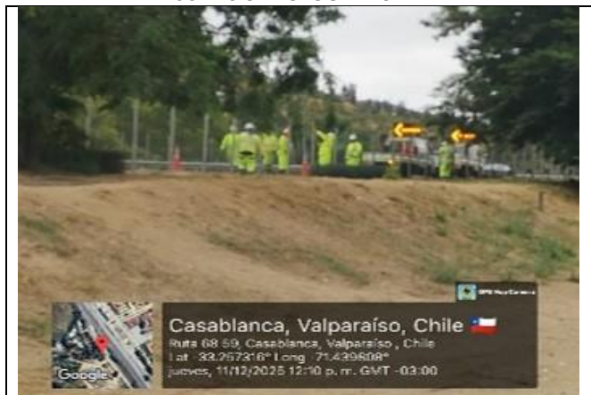
Trabajos de Reposición de cercos dañados
