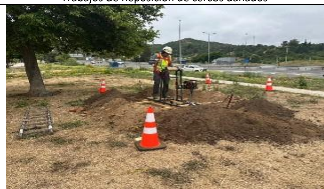
Trabajos de ejecución excavación calicata
