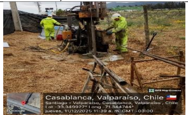
Trabajos de ejecución sondaje muestras de material
