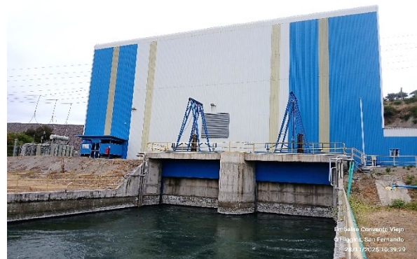
Imagen N°4. Vista general de la Central Hidroeléctrica.
