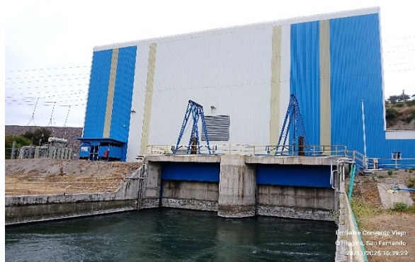
Imagen N°4. Vista general de la Central Hidroeléctrica.
