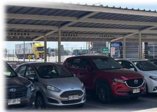
Zona de estacionamientos
