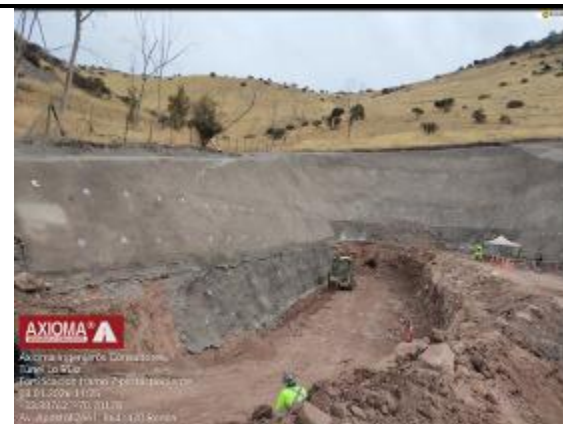
Fortificación Tramo N°7 Portal Poniente.
