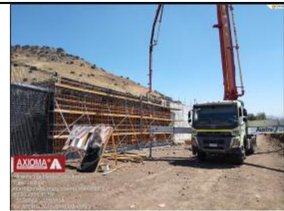
Hormigonado Muro Oriente Tramo N°3 (E3)
