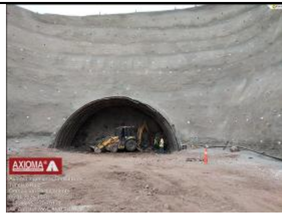
Demolición Bóveda Túnel Sur Oriente
