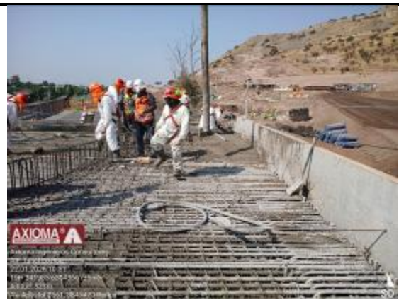
Hormigonado Losa Superior Tramo N°3 (E3).
