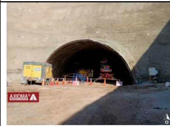
Colocación Micropilotes Túnel Sur Poniente.
