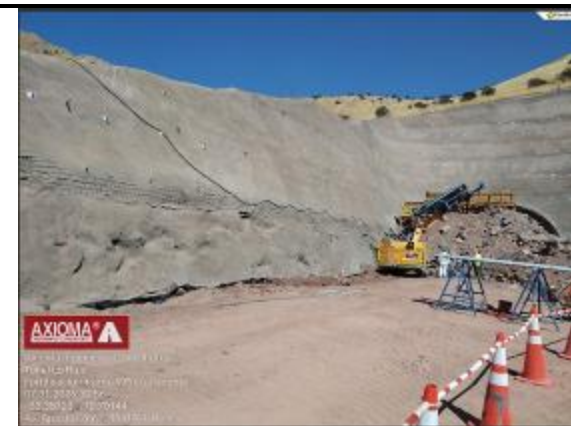
Fortificación Tramo N°9 Portal Sur Oriente.
