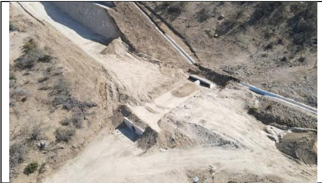
Fotografía N°1, Vista OA N°15. Variante Ruta E-315
