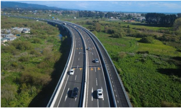
Sector C – Puente estribo sur - San Pedro de la Paz
