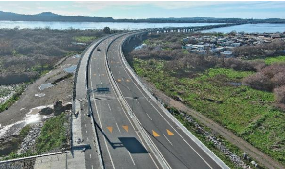
Sector C – Estribo Salida lado sur – San Pedro de la Paz
