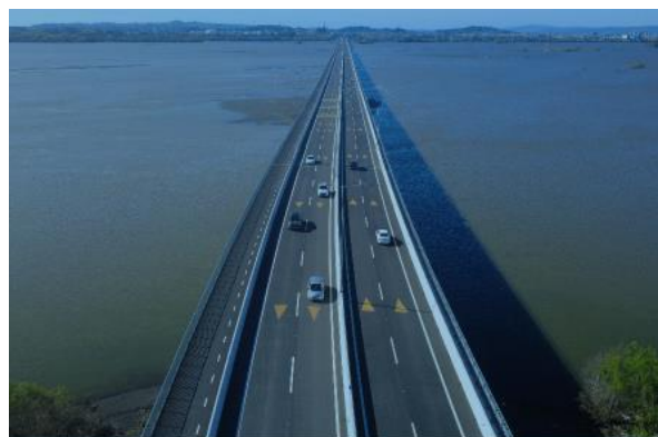
Sector B –Desde estribo Entrada norte – Hualpén
