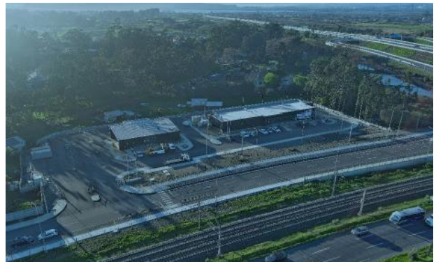
Sector C – Edificio de Control y Emergencias
