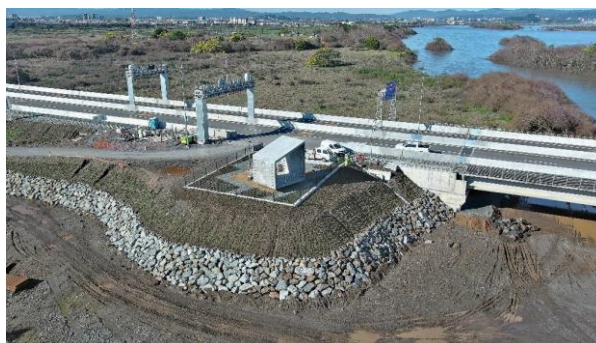
Sector A – Mirador – Hualpén
