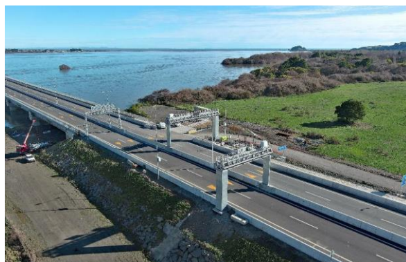
Sector A – Pórticos telepeaje – Hualpén
