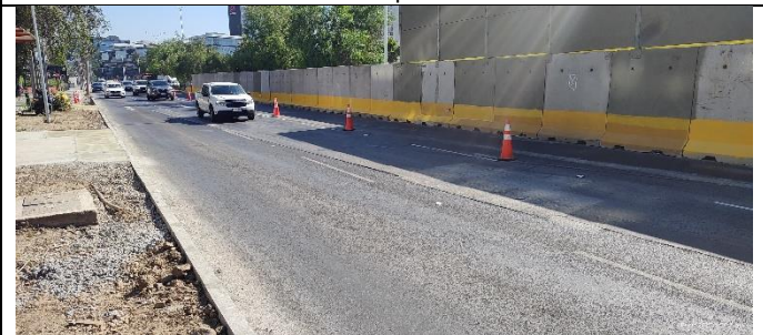
Desvío Trinchera Blest Gana fase 2
