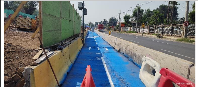
Desvío Acueducto Agua Potable
