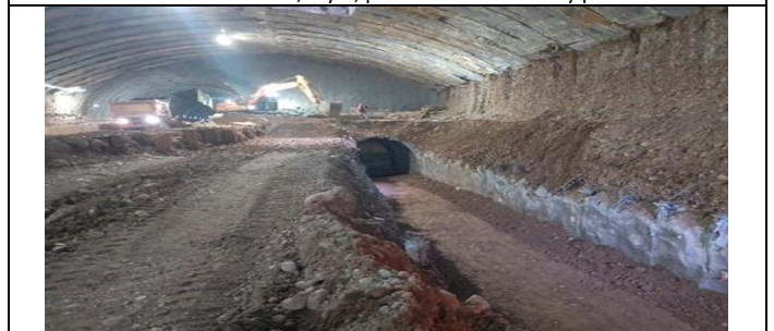
Frente 8, Túnel Alemán: Se avanza en rebaje de piso, rellenos. Nivelación y compactación para cota de emplantado de losas..
