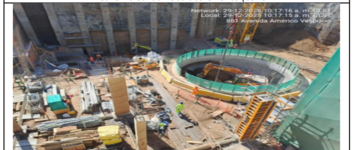
Sector Edificio de Control: Brocal del Pique E. Castillo Velasco.
