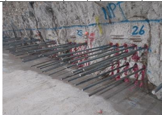
Frente 8, Túnel Alemán Se terminó perforación e instalación de barras conectoras losas- galerías laterales.
