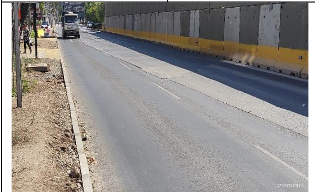
Desvío Trinchera Blest Gana fase 2
