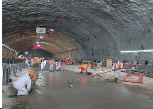
Frente 7, Túnel Híbrido: Se terminó confección de enplantillados para losas en secciones A, B, C y D por costados oriente y poniente
