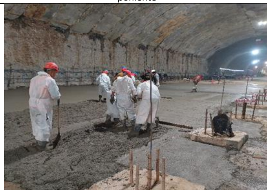
Frente 8, Túnel Alemán Se terminó rebaje de piso, rellenos, nivelación y compactación a cota de subrasante para enplantillado de losas superiores y la ejecución del enplantillado
