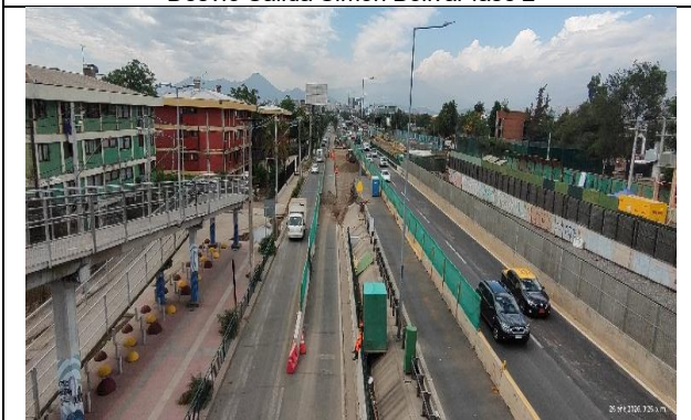
Desvío Trinchera Vía Expresa Poniente fase 2
