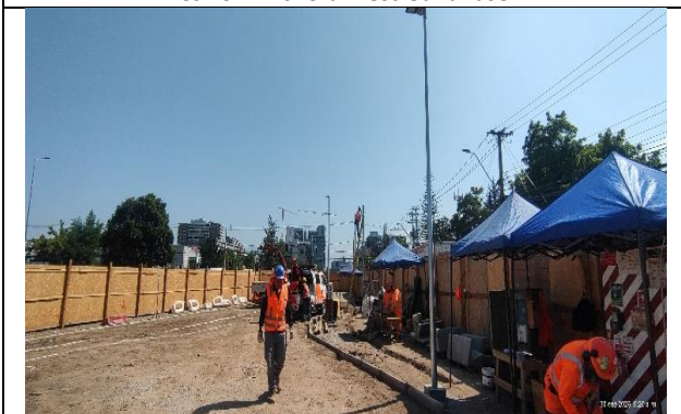
Obras reposición plaza sector Av. Egaña
