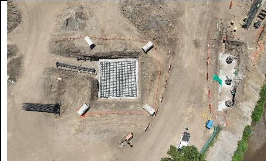
Estribo Entrada Viaducto Ruta 78
