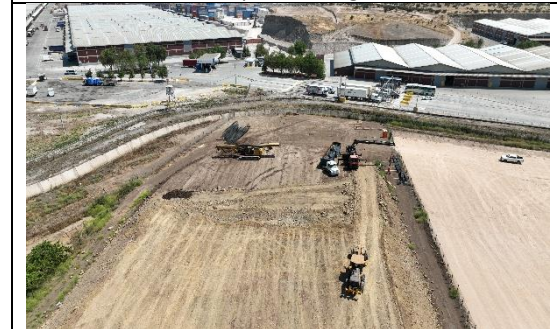
Paso Superior Canal Ortuzano
