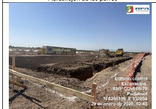
Edificio control y emergencia.
