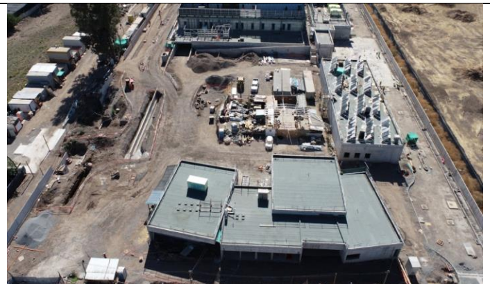
5.- Edificios REAS (atrás) e Instalaciones (a la derecha)
