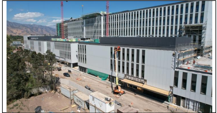
4.- Fachada Norte-Sector central
