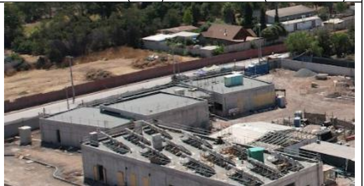
6.- Edificio Sala Cuna
