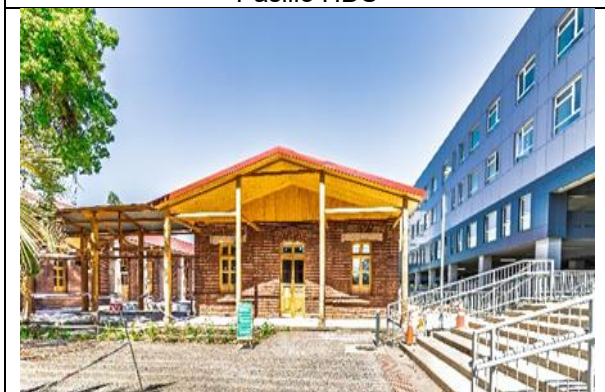
Fachada Pabellón Histórico
