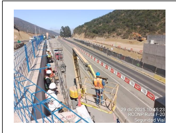
Sector 1, Sector Cumbres Dm. 10.900 app. Avance Muro TEM Enlace Cumbre
