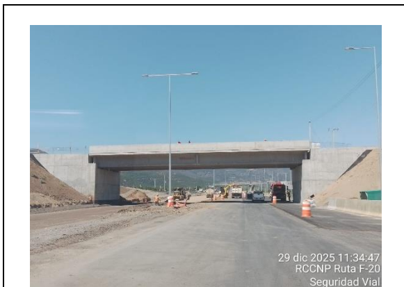
Sector 1, Km 4.8 a 5.5 app. F-20 Trabajos de Construcción Paso Inferior Dm. 4.800
