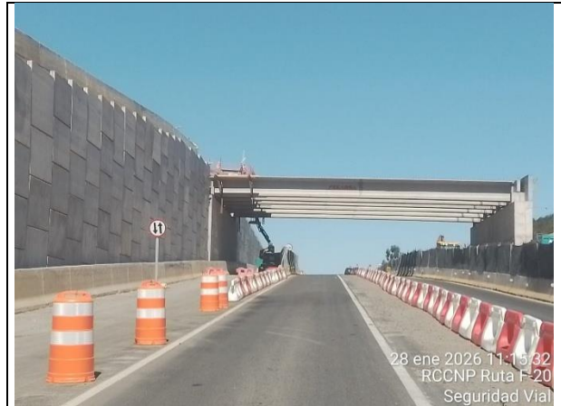
Sector 1. Sector Cumbres Dm. 10.900 app. Trabajos en Vigas y Muros Tem.
