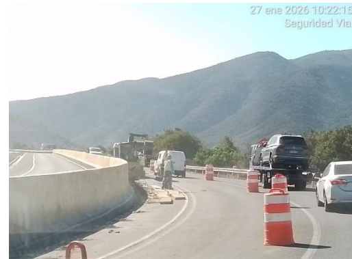
Sector 1 Sector Cuesta Dm 14.000 Trabajos de Saneamiento y Drenaje
