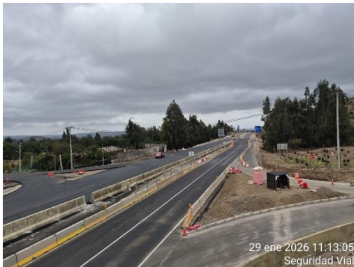
Pasarela N°4 Dm 16.500 Pavimentos y Obras de Arte
