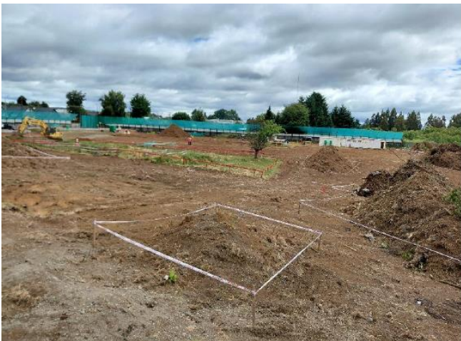
Hospital La Unión (sin movimiento)
