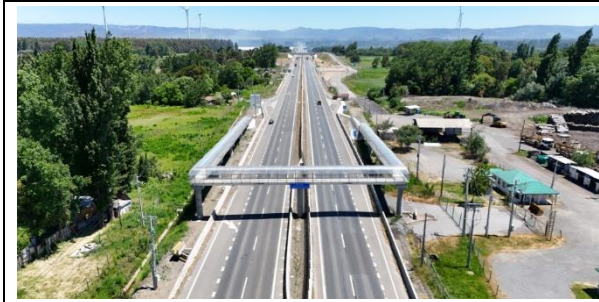
Ilustración N°5: Pasarela Chequen Dm 20.610
