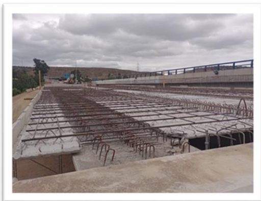
Foto 3: Ruta 5, Puente Quebrada Seca, Instalación de pre- losas y enfierradura.
