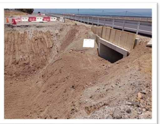
Foto 5: Ruta 5, Atravesio Puerto oscuro, Proceso de excavación lado oriente.
