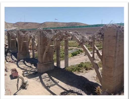
Foto 4: Ruta 5, Puente Limarí, Vista general de demolición.
