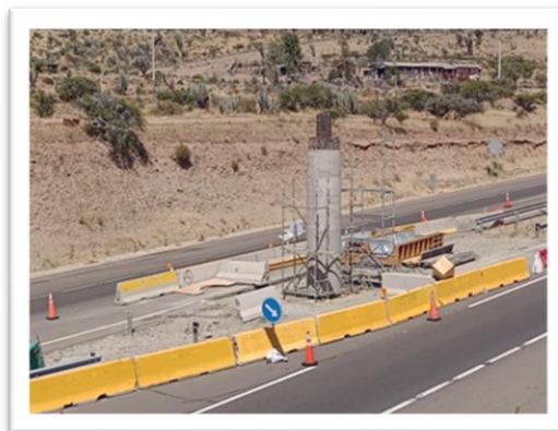
Foto 6: Ruta 5, Pasarela Salala, pilar central sobre mediana de ruta 5.
