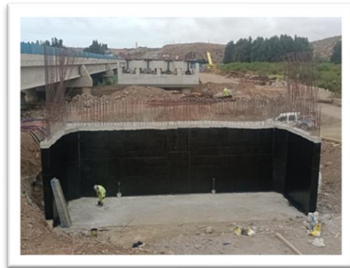
Foto 2: Ruta 5, Puente Huentelauquen Oriente, muro de estribo de Acceso.
