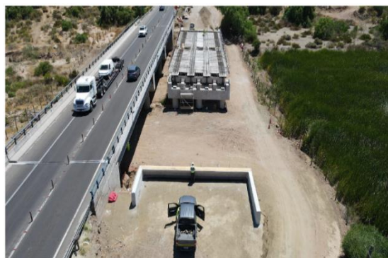
Trabajos Puente Quebrada Seca
