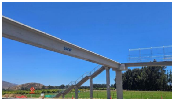
PASARELA MINCHA SUR.
