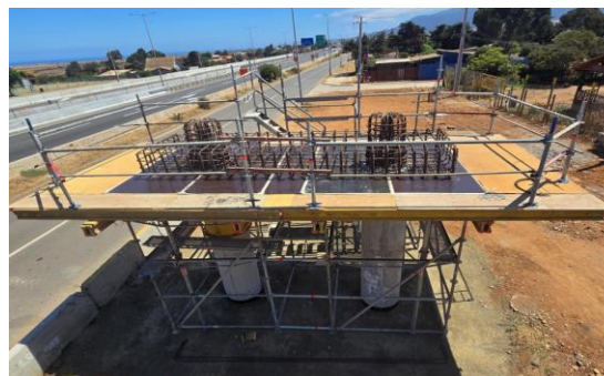
Pasarela Illapel Norte.
