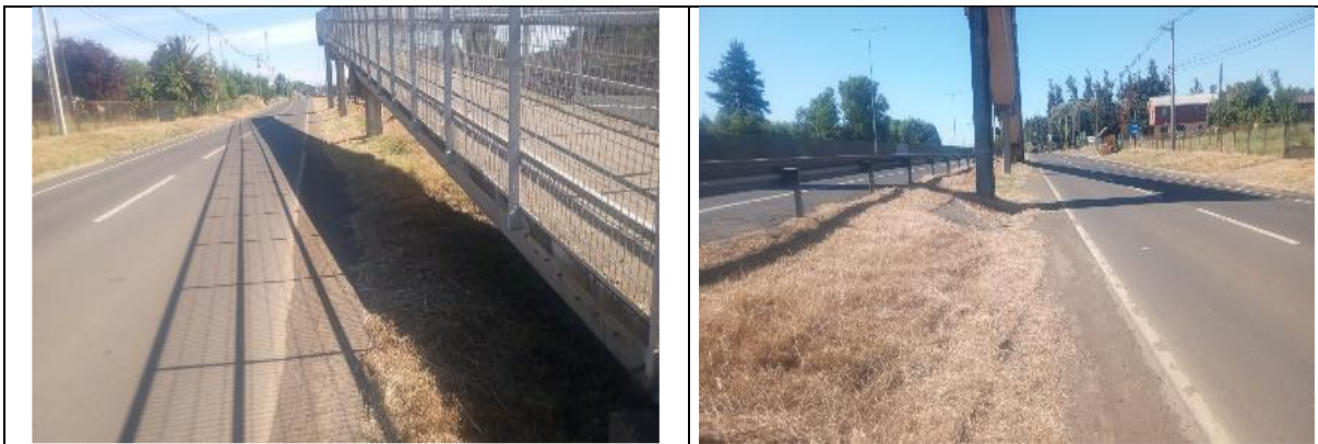
Trabajos de Conservación Calle de Servicio Santa Clara
