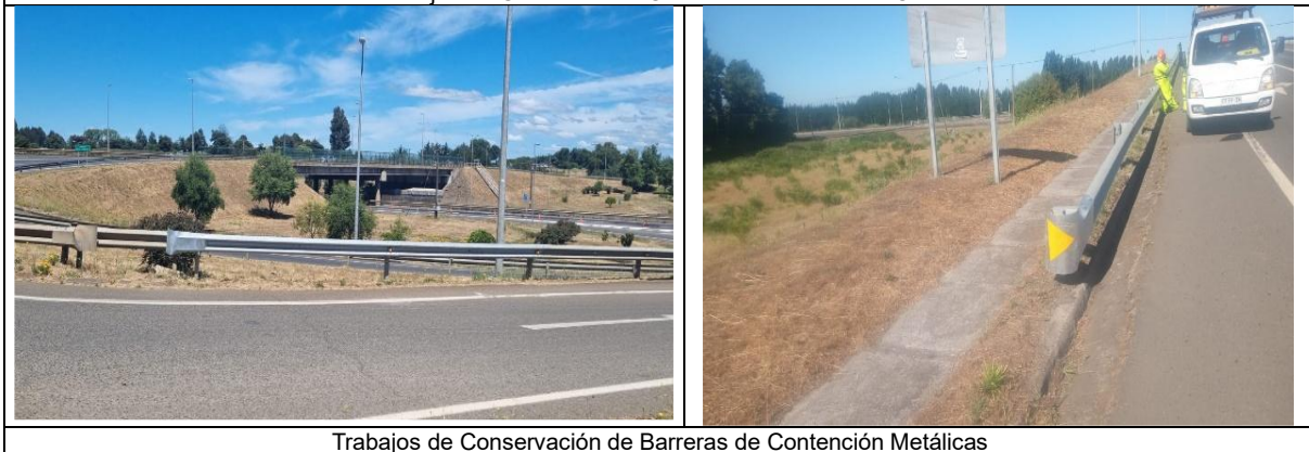
Trabajos de Conservación de Barreras de Contención Metálicas
