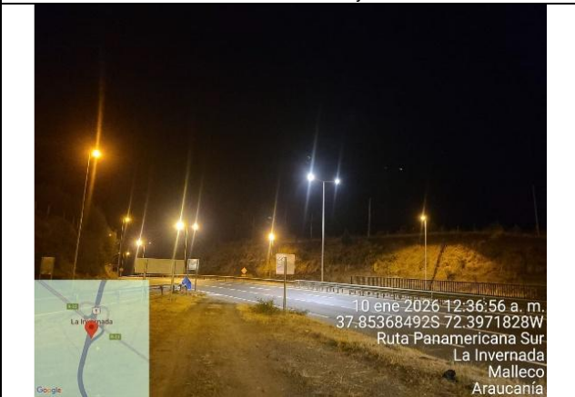
Mantenimiento de Luminarias
