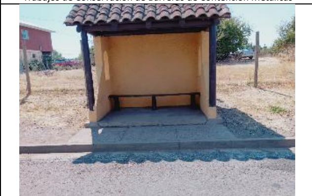
Mantenimiento de paraderos de Buses
