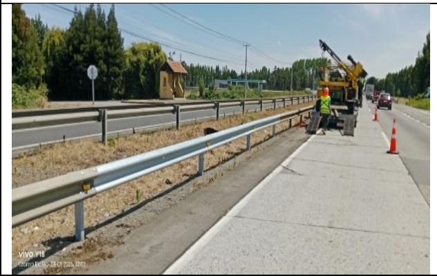
Trabajos de Conservación de Barreras de Contención Metálicas
