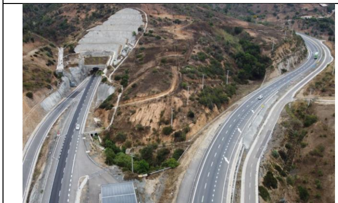
Acceso Norte Túnel El Melón (km 135)
