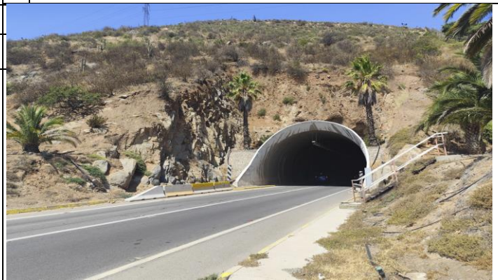
Acceso Sur Túnel La Calavera (km 93.6)
