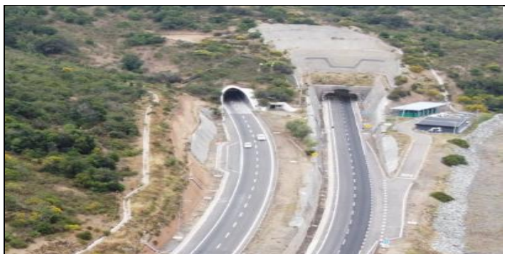
Acceso Sur Túnel El Melón (km 129)
