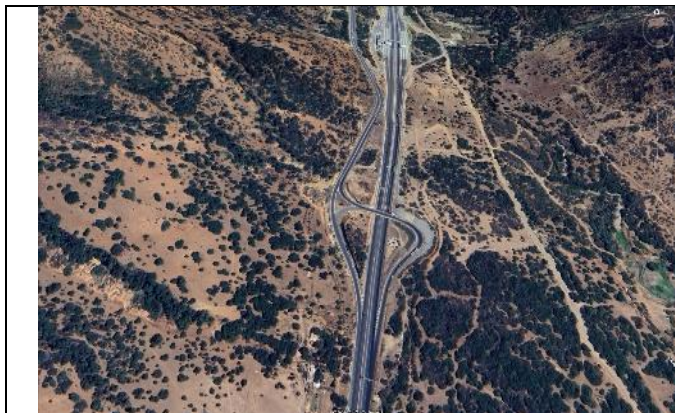
Inicio Concesión Túnel El Melón (km 124.54)
